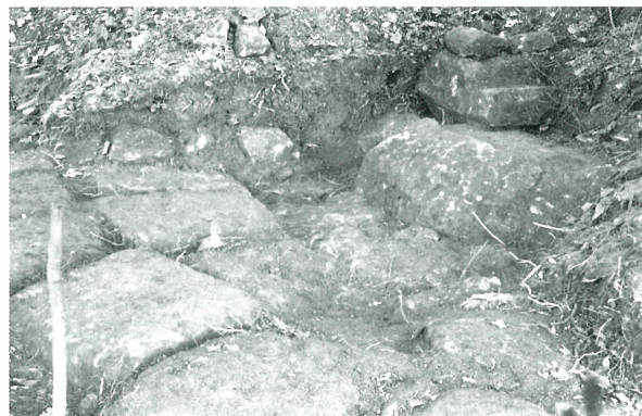
8 舗石及護石地覆角石 北北西角 正面斜(13-10)
