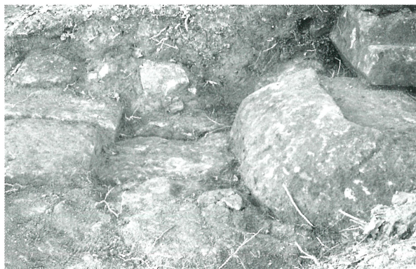
7 舗石及護石地覆角石 北北西角 正面斜 (13-9)
