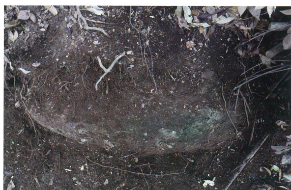
4 西北西部 地覆石 (C地点) 上から
