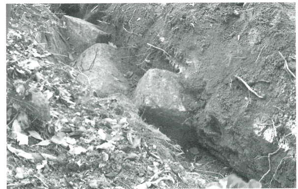
6 北部舗石 上 崩落石 (12-29)
