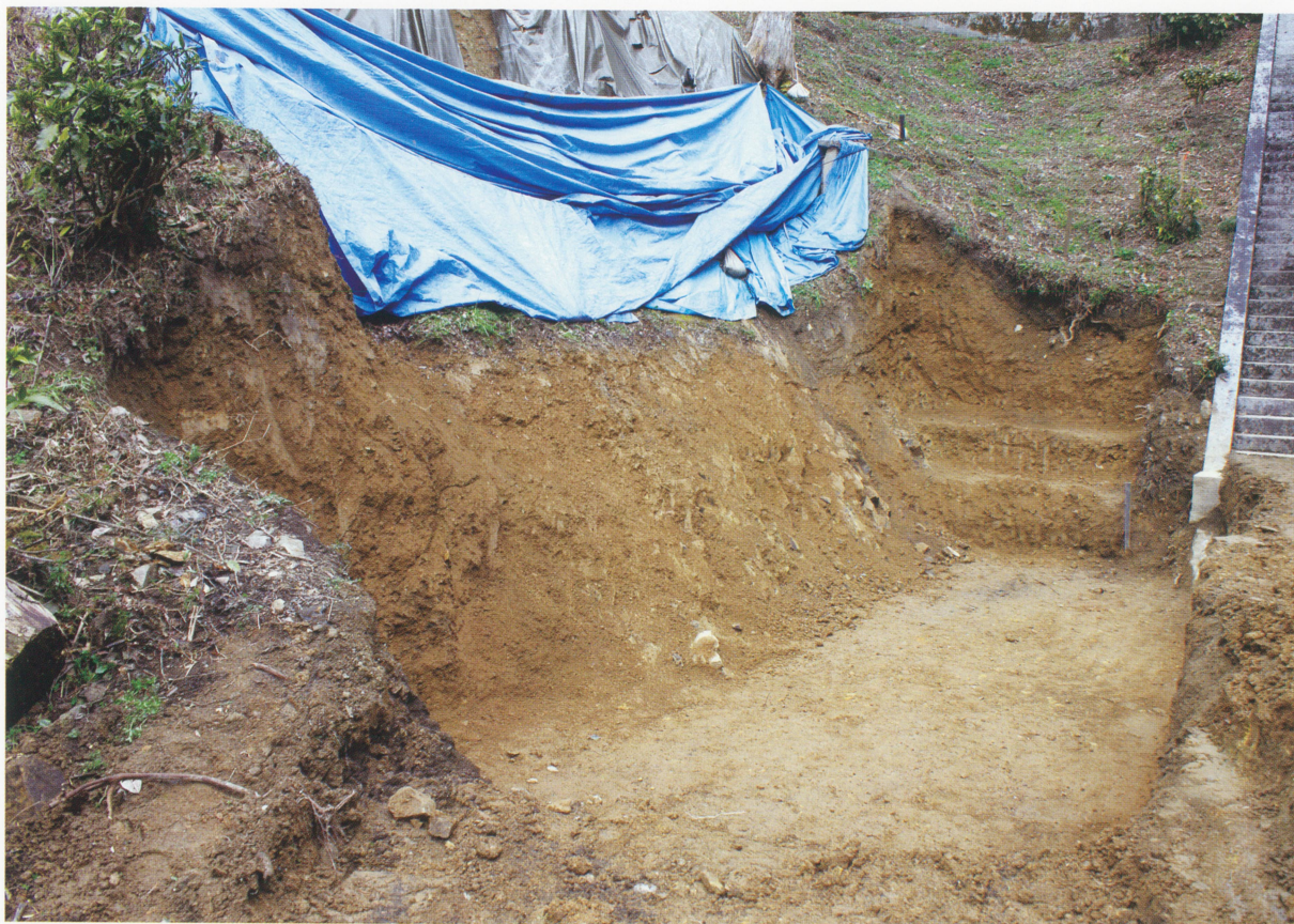
1 斜面下箇所全景（南東から）
