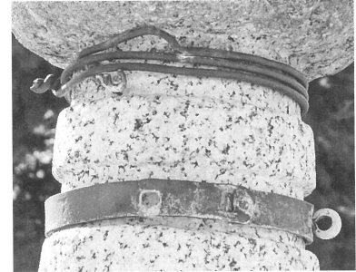
3 現況写真（相輪上部、北東面）
