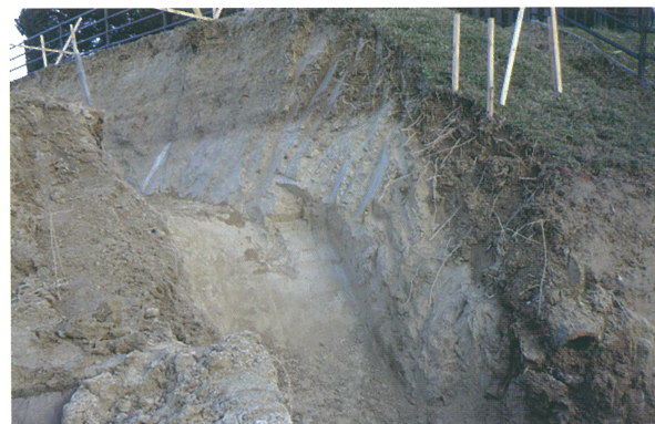
4 石積工箇所 界 17 号付近から (東へ)
