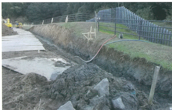
1 石積工箇所 界 11 号付近から (東へ)
