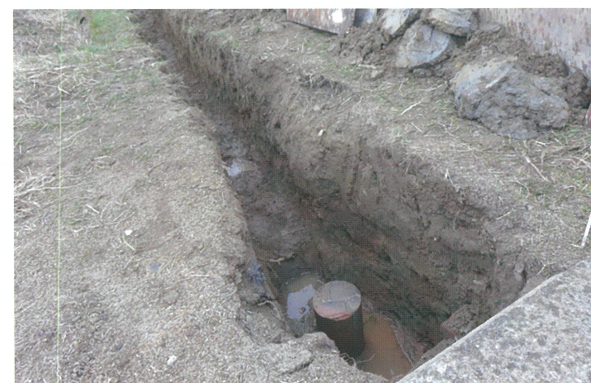
8 排水工箇所 ウ区 (西から)
