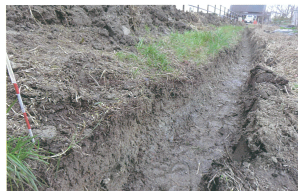
7 排水工箇所 ア区 (東から)
