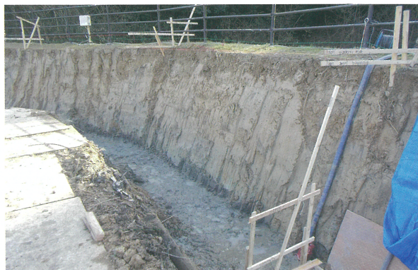
2 石積工箇所 界 13 号付近から (東へ)
