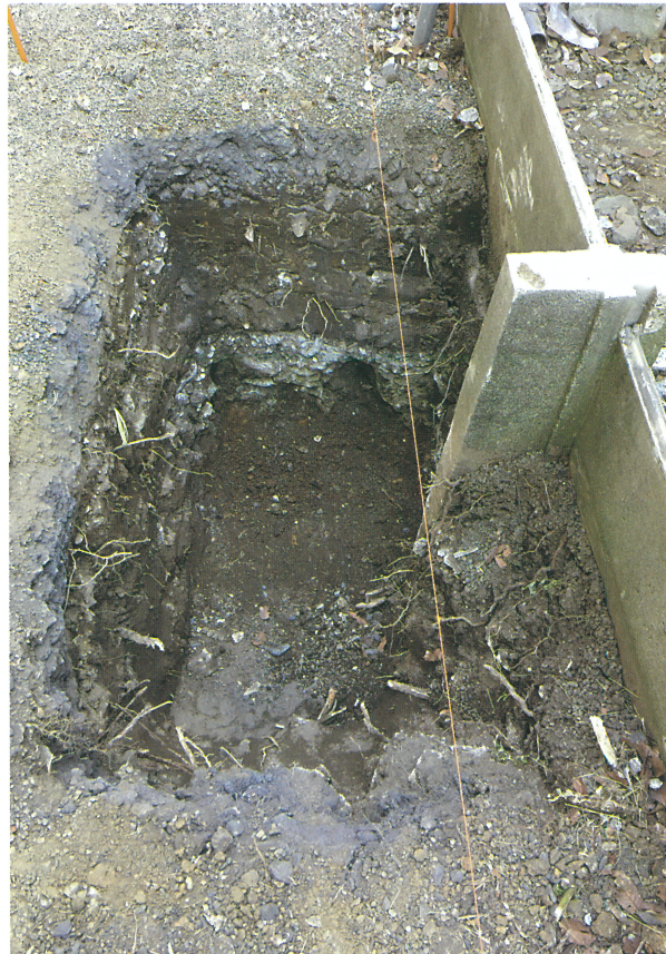
3 Bブロック掘削箇所（北から）
