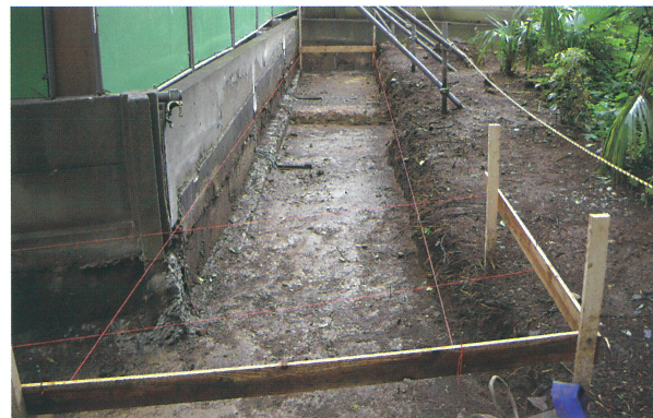
5 EFブロック掘削箇所（東から）
