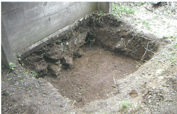
4 Cブロック掘削箇所（東から）
