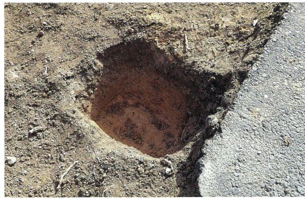
3 車止め2(西から)
