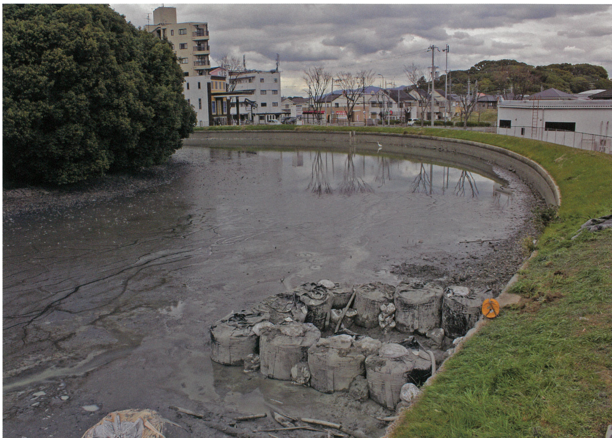
1 調査地遠景(南西から)
