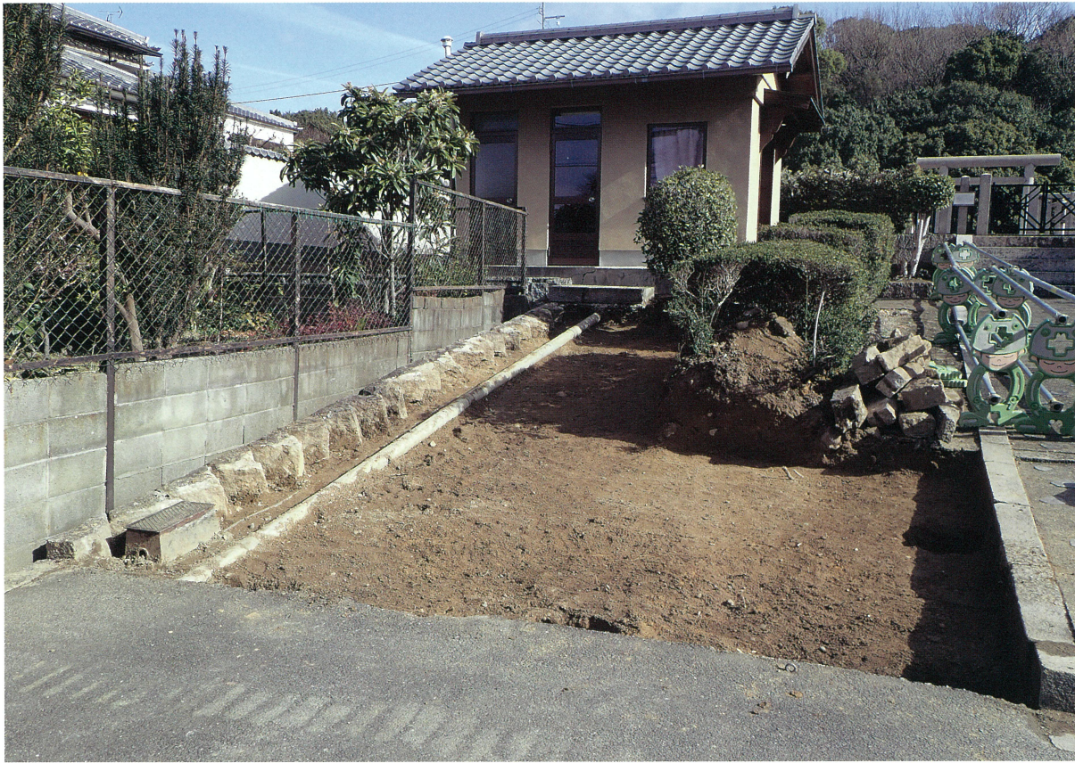
1 調査箇所全景(南西から)
