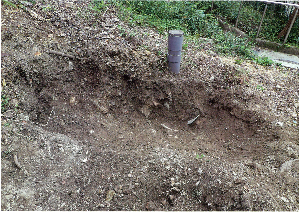
1 調査箇所全景(北西から)
