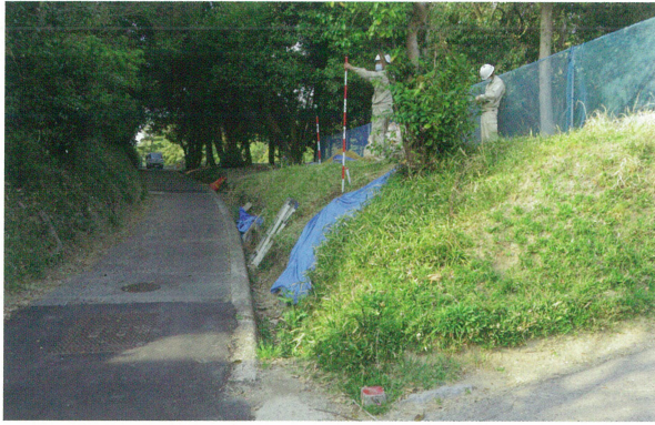
1 電柱・支線設置箇所 全景（南から）
