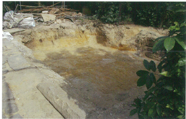
4 旧事務所撤去箇所 全景（北西から）
