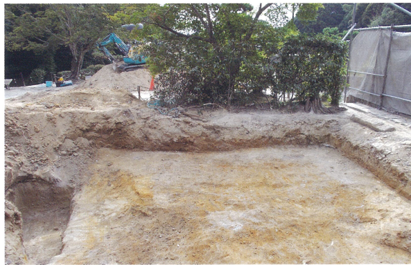
2 旧事務所撤去箇所 西壁（東から）
