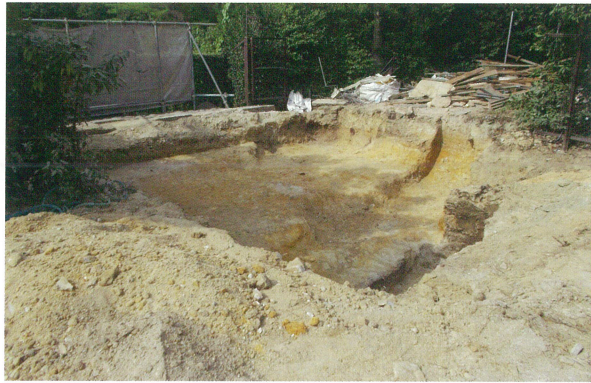
3 旧事務所撤去箇所 全景（南西から）
