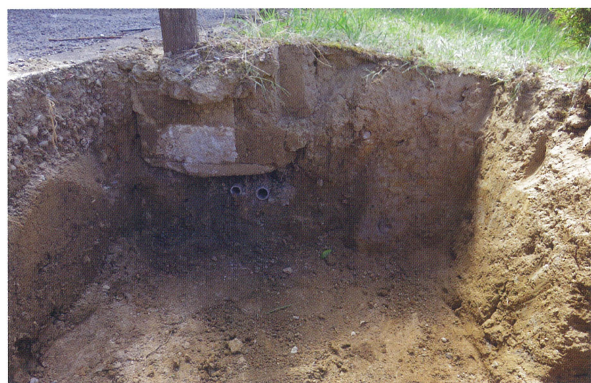
7 電気設備撤去箇所 第3地点 西壁（東から）
