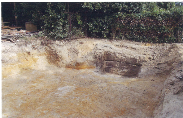
1 旧事務所撤去箇所 南壁（北西から）
