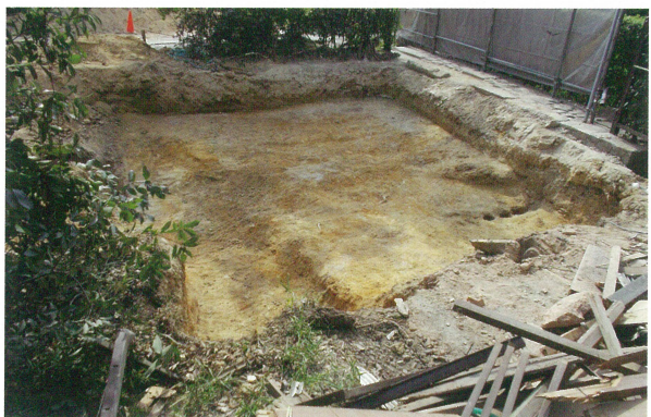
6 旧事務所撤去箇所 全景（南東から）
