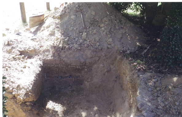
8 電気設備撤去箇所 第4地点 西壁（東から）
