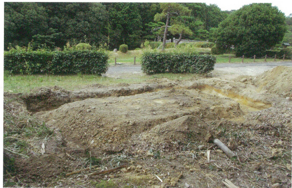
4 旧倉庫撤去箇所 全景（南西から）
