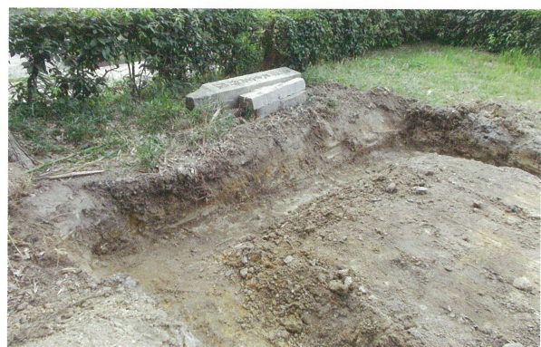
8 旧倉庫撤去箇所 北壁（南東から）
