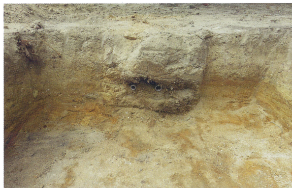
6 電気設備撤去箇所 第2地点 南西壁（北東から）
