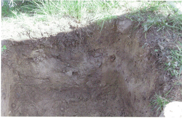
1 電気設備設置箇所 第5地点 北壁（南から）
