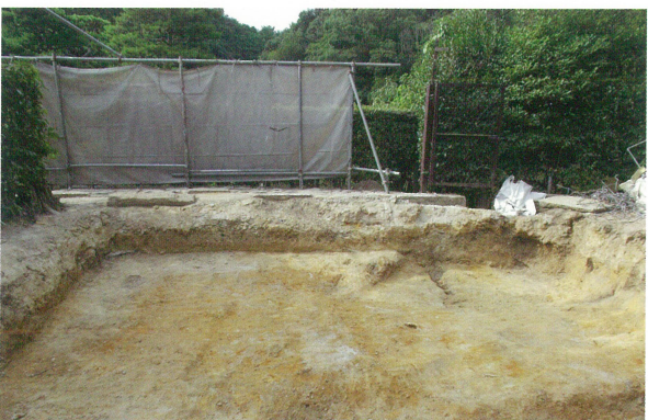
7 旧事務所撤去箇所 北壁（南から）
