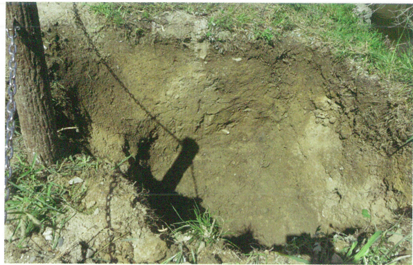
2 電気設備撤去箇所 第5地点 西壁（東から）
