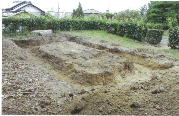
3 旧倉庫撤去箇所 全景（南東から）
