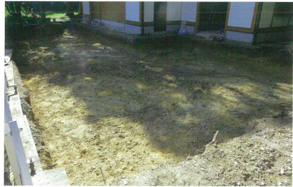
2 新事務所前舗装箇所 全景（南東から）
