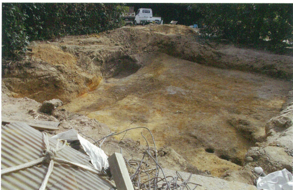
5 旧事務所撤去箇所 全景（北東から）
