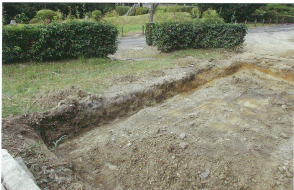
5 旧倉庫撤去箇所 北壁（南西から）
