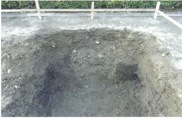
1 東柱基礎 北壁（南から）
