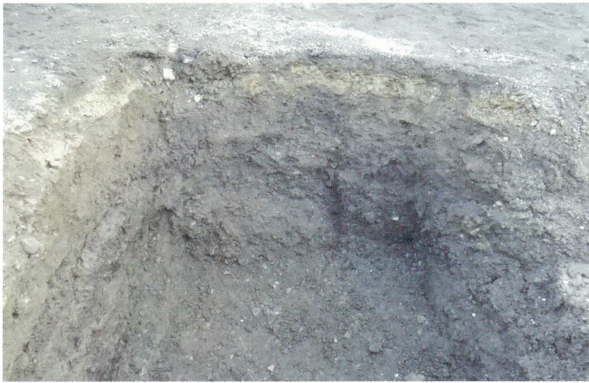
3 東柱基礎 南壁（北から）
