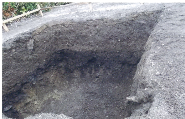
2 東柱基礎 東壁 (南西から)
