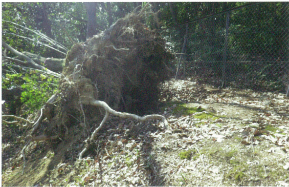
5 根起き箇所 C地点 (北から)
