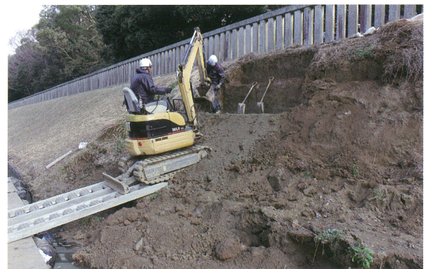
3 第2トレンチ工事掘削（南西から）
