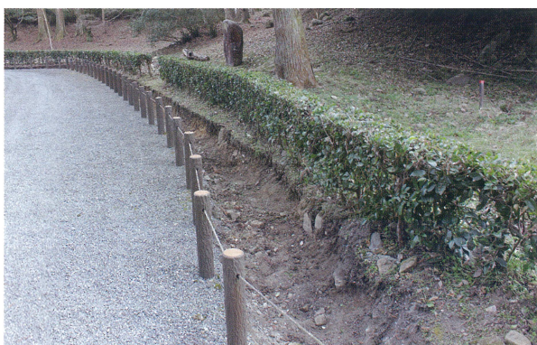
5 D区北壁（北西から）
