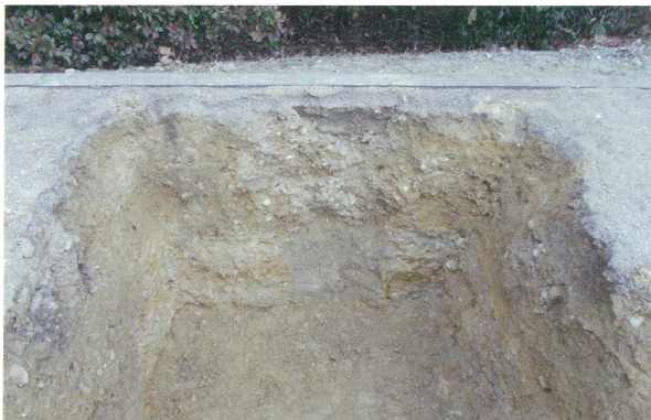
1 東柱基礎 北壁（南から）
