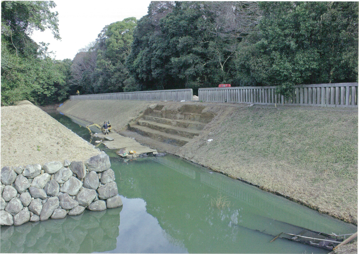
1 調査地全景（南西から）
