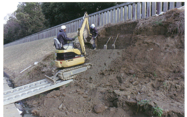
3 第2トレンチ工事掘削（南西から）
