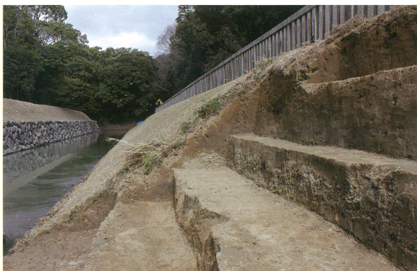
2 第2トレンチ北壁（南から）
