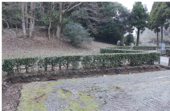
2 B区西壁（東から）
