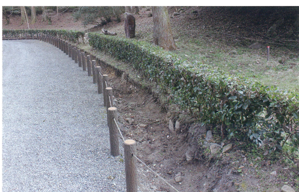
5 D区北壁（北西から）
