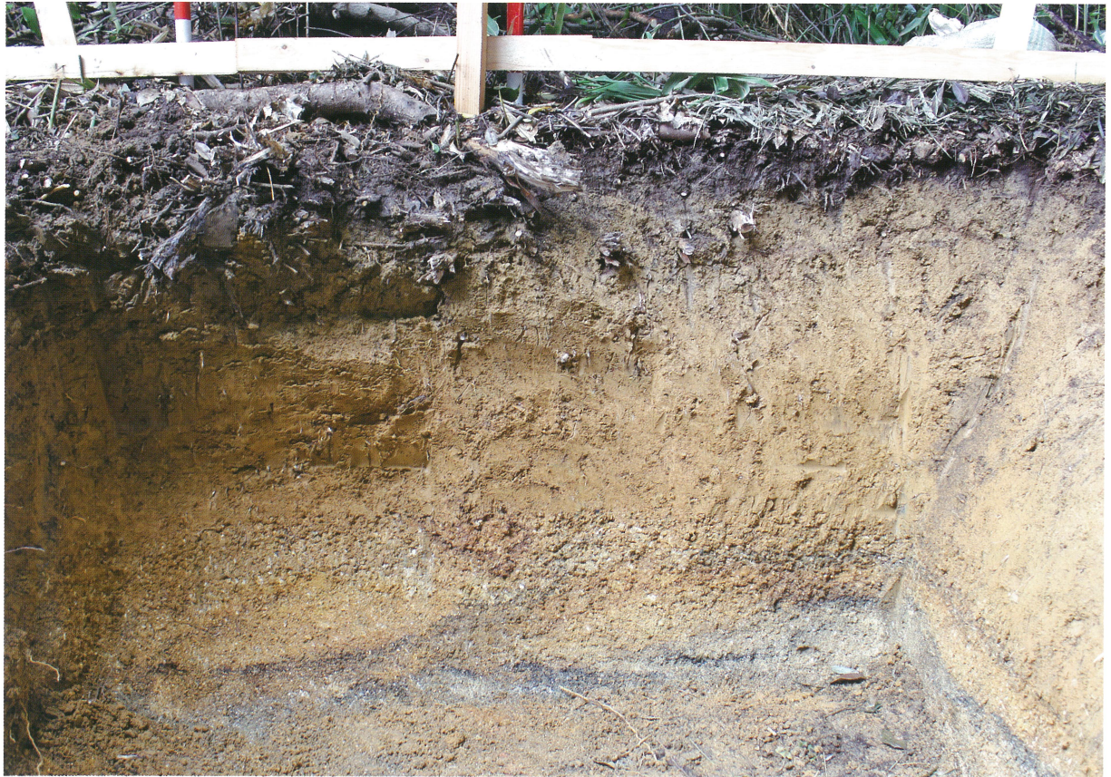
1 重力式擁壁北側北壁（南から）
