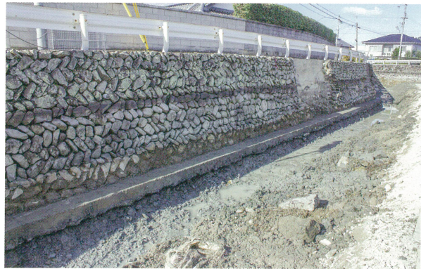
2 調査地西壁南側（南から）
