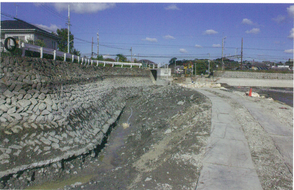
3 調査地西壁北側（南から）
