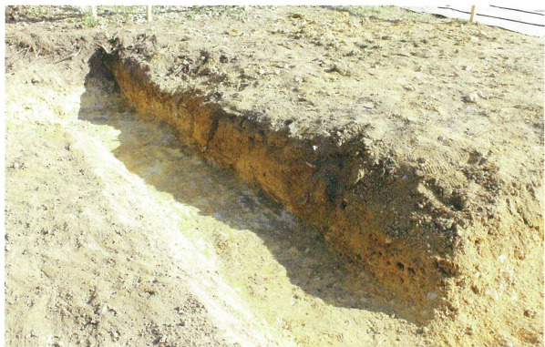
6 事務所基礎部分 E - F間（北西から）
