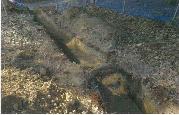
1 管路等部分 上水道等管路 (南東から)
