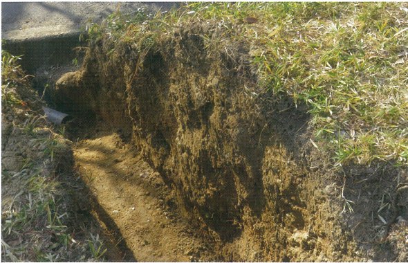
3 管路等部分 下水道等管路 西端付近 (南東から)
