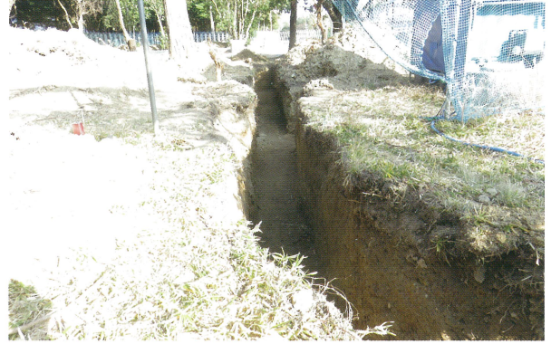
2 管路等部分 下水道等管路 (西から)
