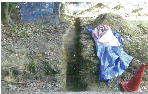
8 管路等部分 上水道等管路（西から）
