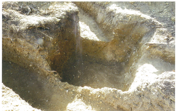
8 管路等部分 電気線ハンドホール設置箇所 (北東から)
