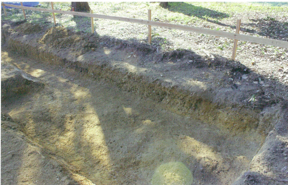
3 事務所基礎部分 B - C間（北東から）
