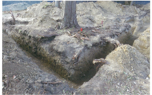
4 管路等部分 下水道等管路 (南東から)
