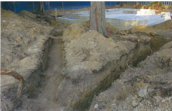
5 管路等部分 電気線管路 (南西から)
