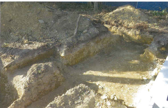
7 管路等部分 汚水枡等設置箇所 (南東から)
