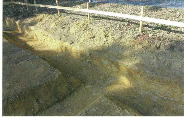
2 事務所基礎部分 A - B間（南東から）
