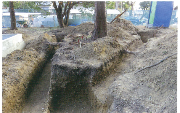
6 管路等部分 電気線管路 (北東から)
