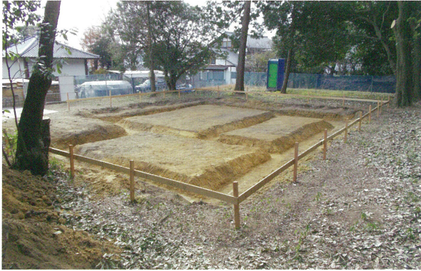
1 事務所基礎部分 全景（北東から）
