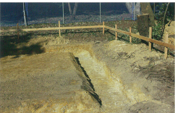
7 事務所基礎部分 F - A間（南西から）
