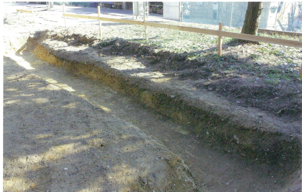
4 事務所基礎部分 C - D間（北西から）
