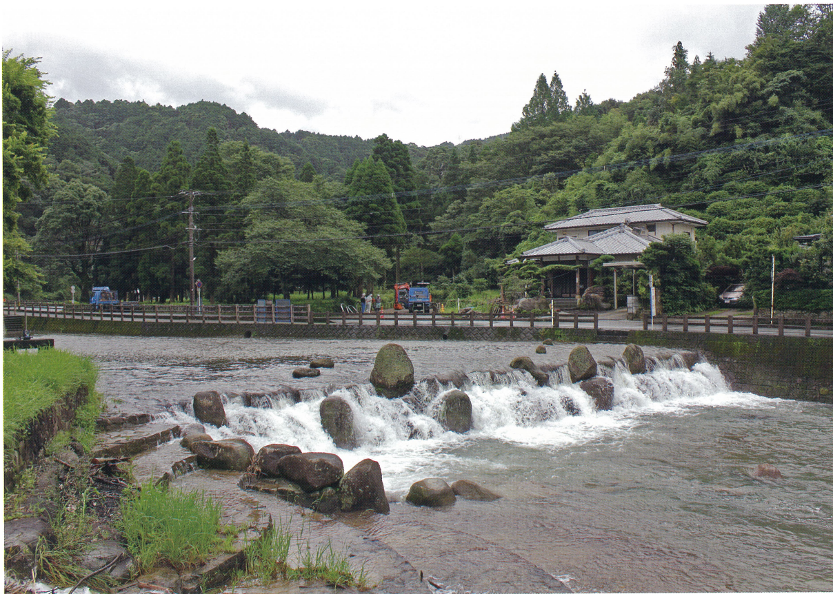
1 調査地 遠景（北から）
