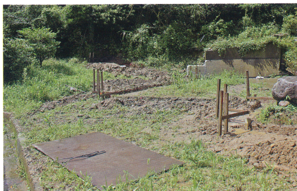
4 外構柵掘削箇所（北東から）
