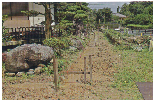
5 外構柵掘削箇所（南から）
