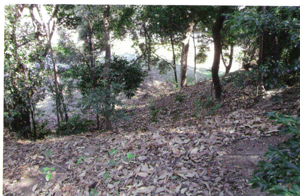
3 後円部墳頂部崩落状況
