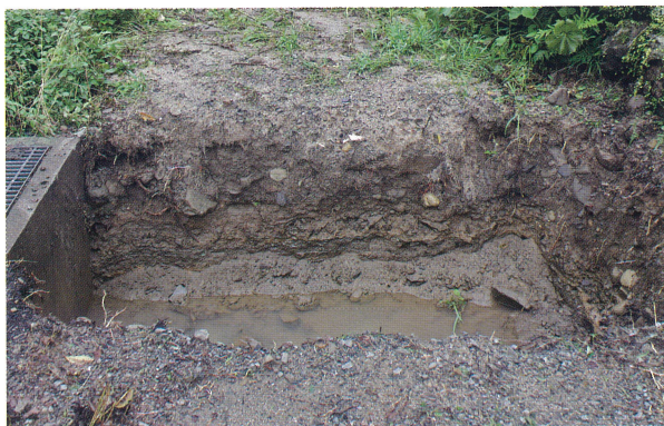
2 制札基礎 南壁（北から）
