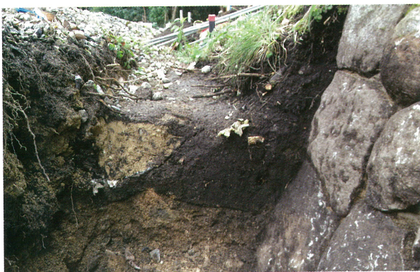
3 域内陪冢り号石積み前面部の土層断面（西から）
