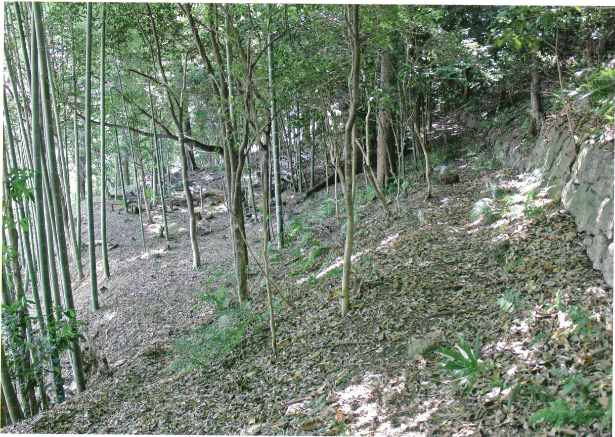
2 調査地⑭ (北側通路、東から)
