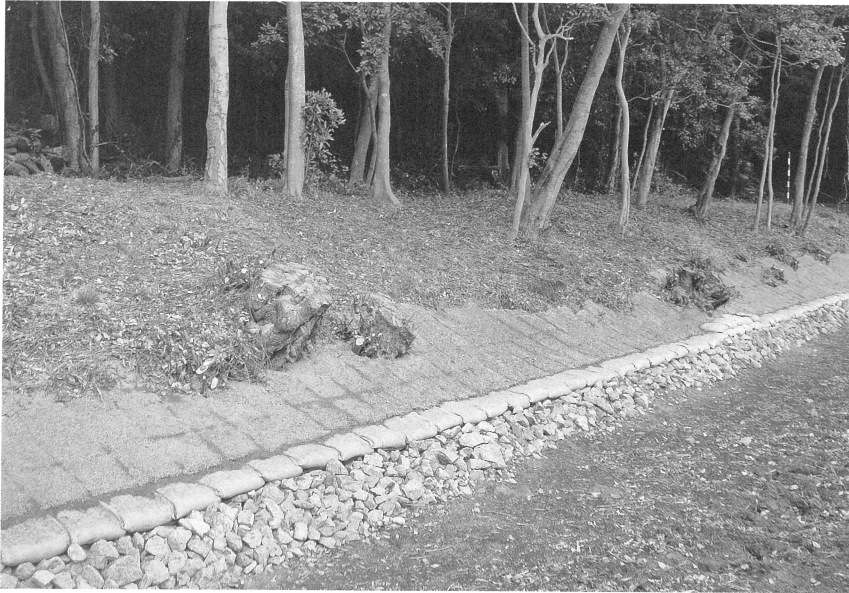
写真7 宇度墓 墳塋護岸施工状況（南濠）
