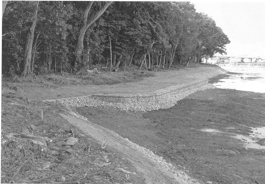
写真8 宇度墓 北造出周辺施工状況
