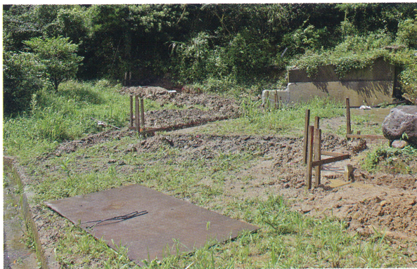
4 外構柵掘削箇所（北東から）
