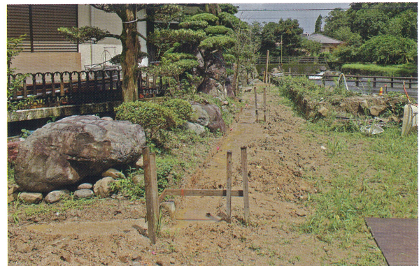
5 外構柵掘削箇所（南から）
