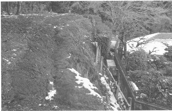
写真1 桃山陵墓地 調査箇所全景 (掘削前)
