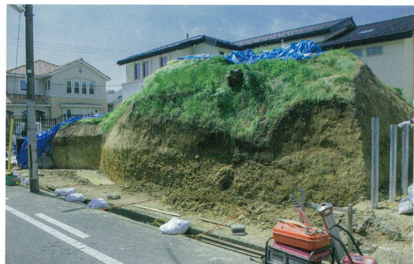
3 南壁（北西から）
