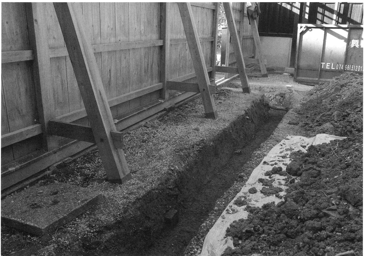
2 第2トレンチ 全景（南東から）
