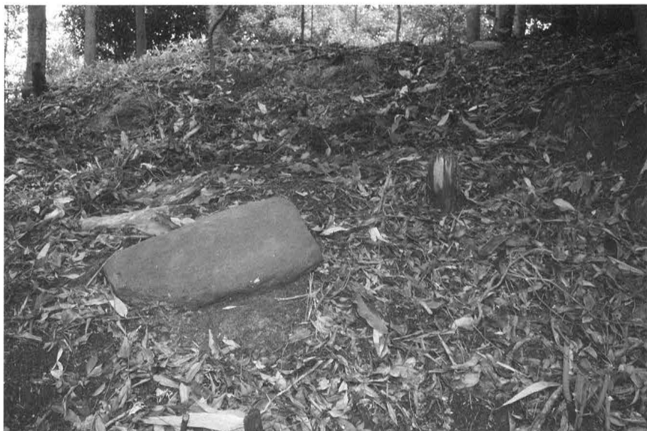
1 墳丘東側崩落箇所 (東から)
