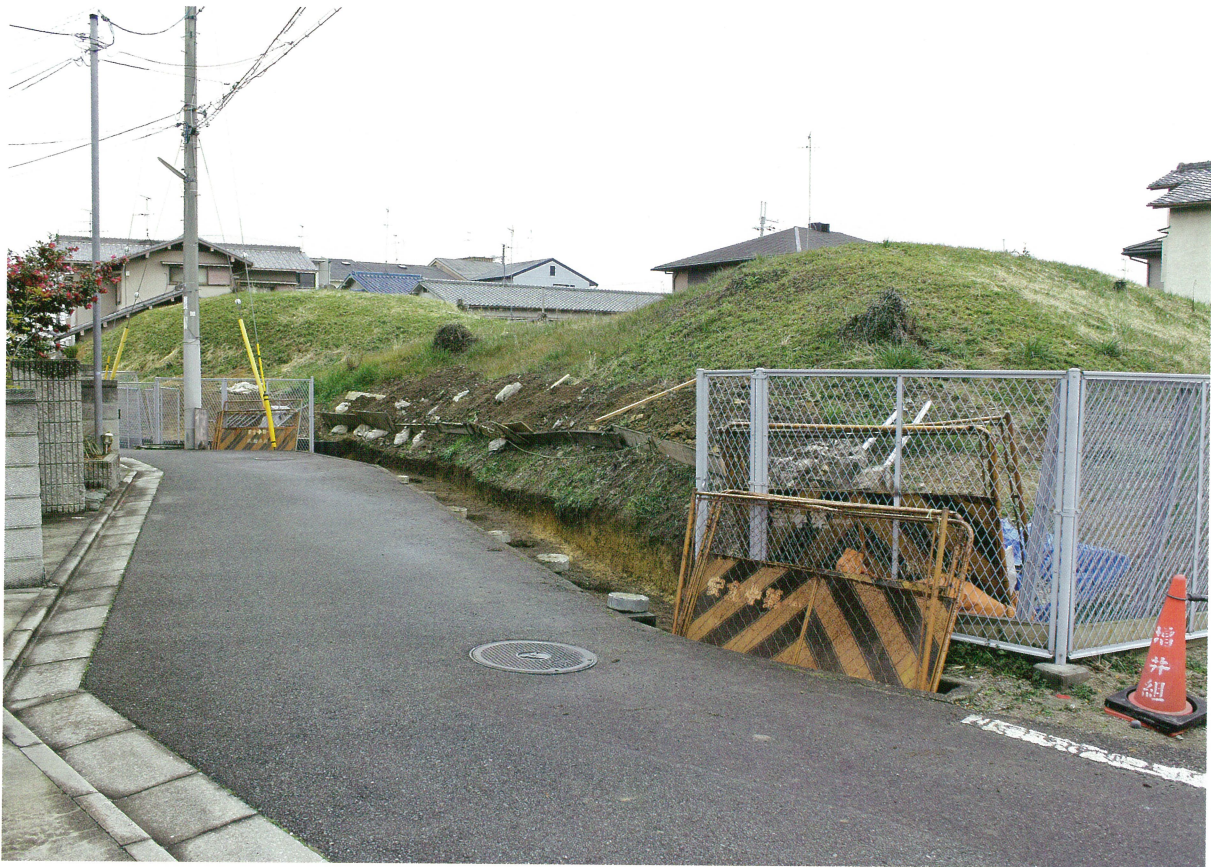
1 調査地(A-C間)全景(北西から)
