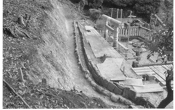
2 排水溝全景（西から）
