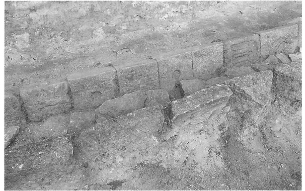
4 排水溝東寄り（南西から）
