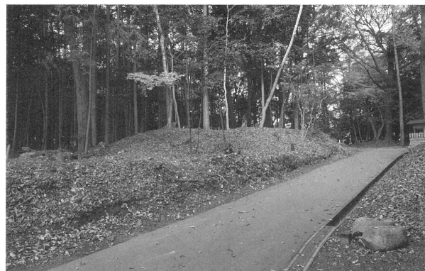
3 城内陪冢ろ号（東から）
