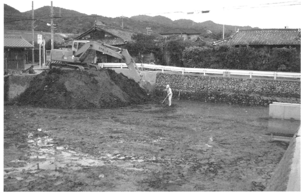
2 堆積土除去工事実施状況（北東から）
