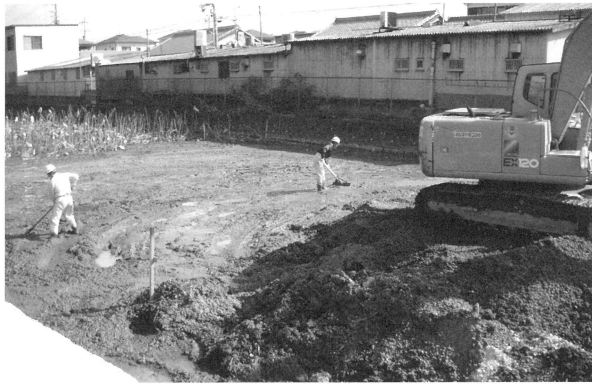
1 堆積土除去工事実施状況（北西から）
