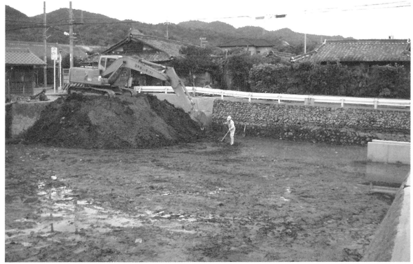
2 堆積土除去工事実施状況（北東から）
