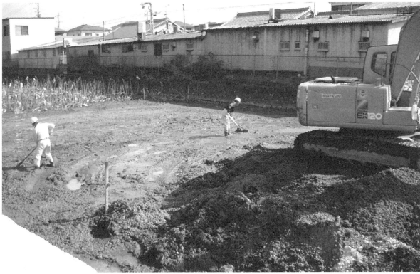
1 堆積土除去工事実施状況（北西から）
