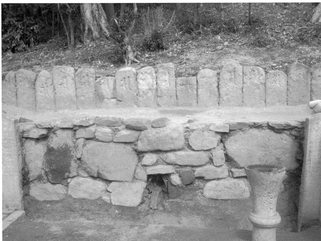
2 磯長墓 結界石据え直し箇所 北壁
