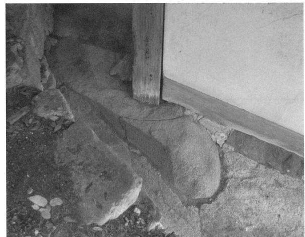
6 磯長墓 石室天井石露出状況（南西から）
