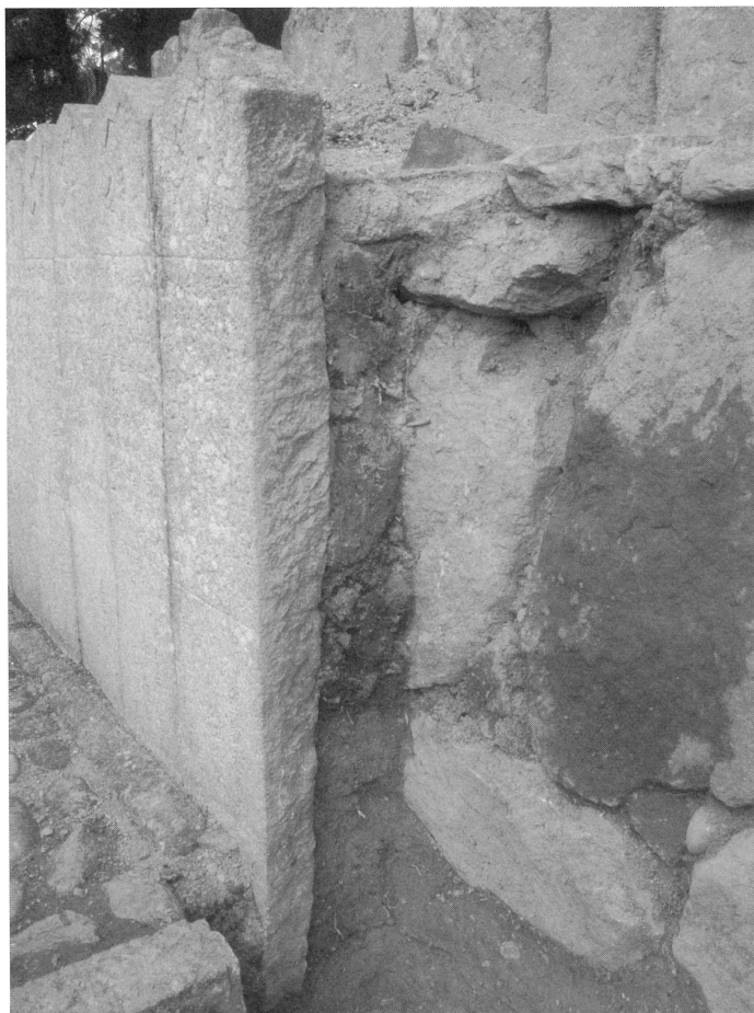
1 磯長墓 結界石据え直し箇所 西壁
