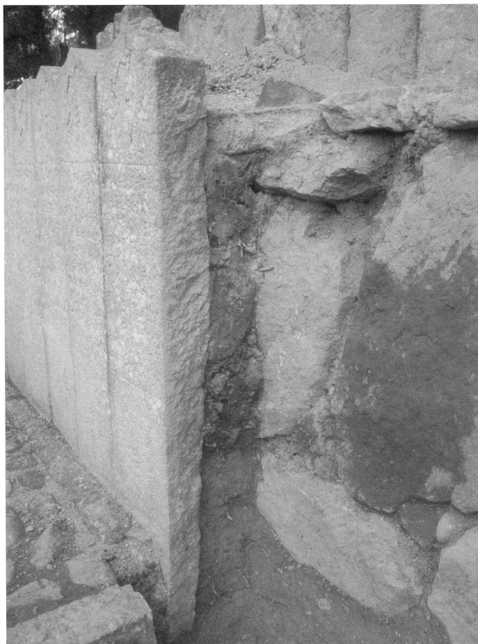
1 磯長墓 結界石据え直し箇所 西壁
