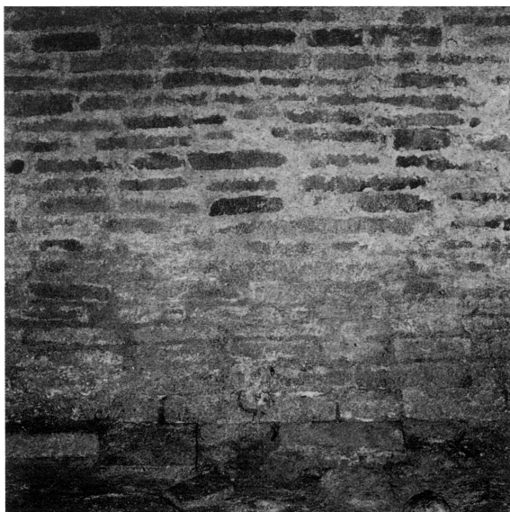
5 玄室 西壁詳細（東から）
